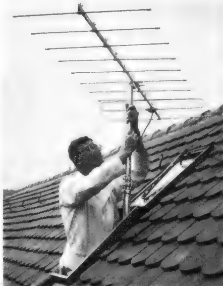
Bild 2. Antennenversuche mit einem Hirschmann-Schiebemast Typ Schima 100
